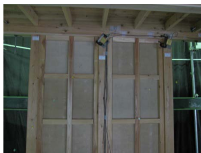
(2) 構面せん断変形の計測 写真 2 計測の状況
