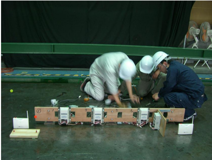
地震感知器の設置風景
