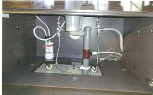
シンク下配管状態
