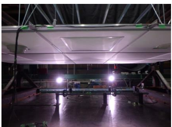
写真6 天井の仕上げ状況
