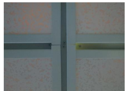
写真4 ハット型ジョイナー-SZ-L ジョイント部
