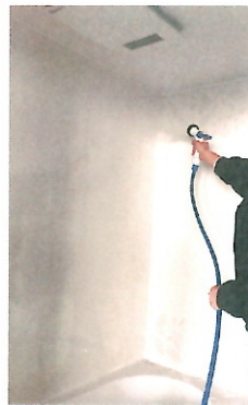
図 3. 防水性能の確認状況
