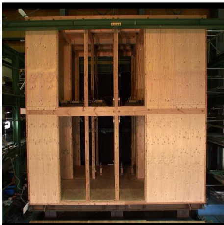
<耐震棟試験体>
